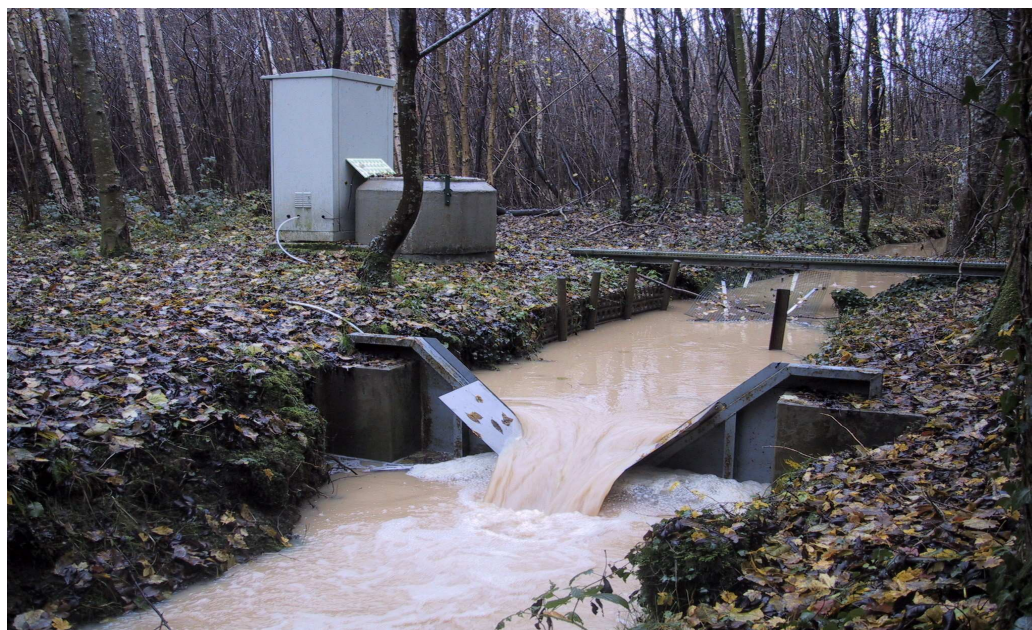
Fig.11 Station de mesures au fossé d'évacuation, exutoire du bassin versant de Goins (source Cemagref)
